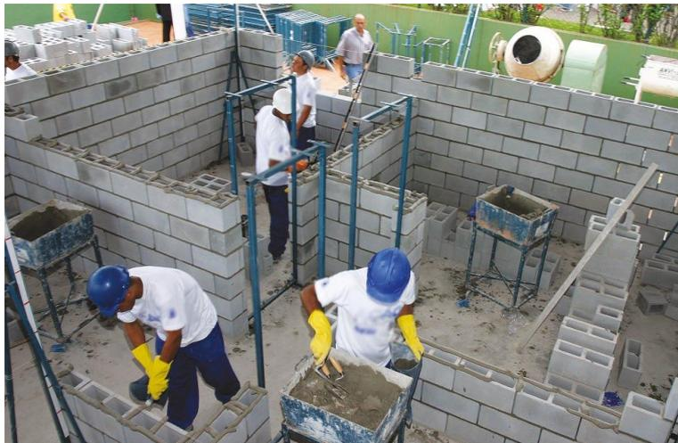
Figura 30 - Alvenaria estrutural
